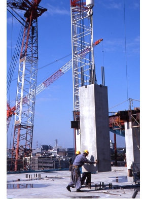
Erection of PCa column
